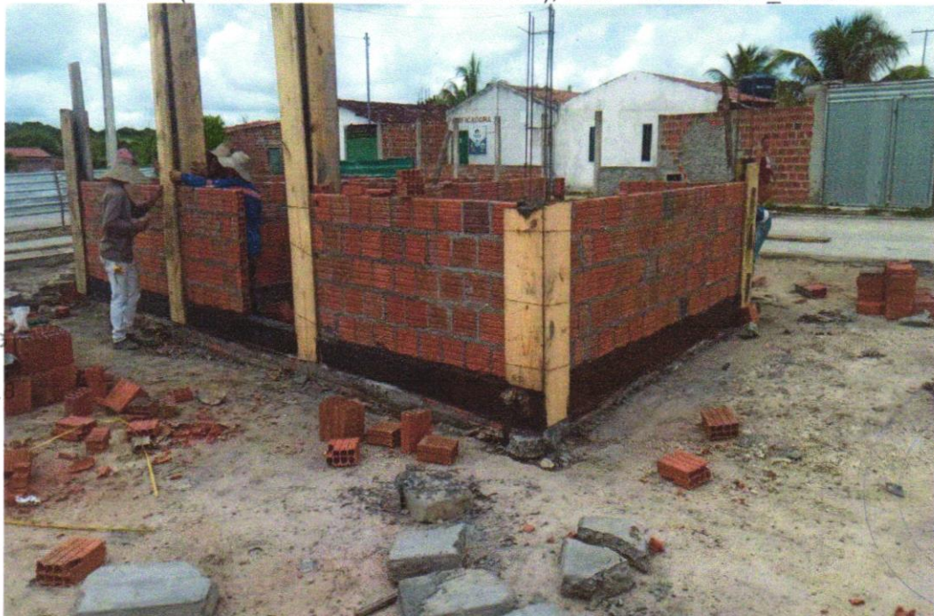
Foto 08 - (COMPOSIÇÃO REPRESENTATIVA) EXECUÇÃO DE ESTRUTURAS DE CONCRETO ARMADO, PARA EDIFICAÇÃO HABITACIONAL UNIFAMILIAR TÉRREA (CASA EM EMPREENDIMENTOS), FCK = 25 MPA. AF_01/2017
