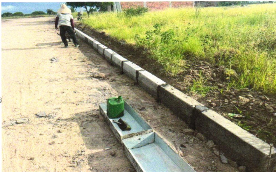
Foto 12 - ASSENTAMENTO DE GUIA (MEIO-FIO) EM TRECHO RETO, CONFECCIONADA EM CONCRETO PRÉ-FABRICADO, DIMENSÕES 100X15X13X30 CM (COMPRIMENTO X BASE INFERIOR X BASE SUPERIOR X ALTURA), PARA VIAS URBANAS (USO VIÁRIO). AF_06/2016
