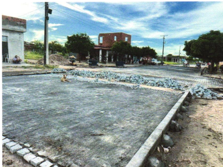
Foto 14 - ASSENTAMENTO DE GUIA (MEIO-FIO) EM TRECHO RETO, CONFECCIONADA EM CONCRETO PRÉ-FABRICADO, DIMENSÕES 100X15X13X30 CM (COMPRIMENTO X BASE INFERIOR X BASE SUPERIOR X ALTURA), PARA VIAS URBANAS (USO VIÁRIO). AF_06/2016
