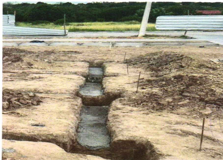
Foto 04 - ESCAVAÇÃO MANUAL PARA BLOCO DE COROAMENTO OU SAPATA (INCLUINDO ESCAVAÇÃO PARA COLOCAÇÃO DE FÔRMAS). AF_06/2017
