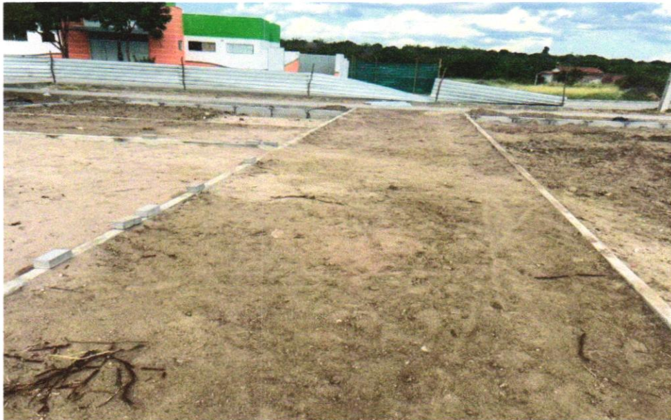
Foto 02 - REGULARIZAÇÃO E COMPACTAÇÃO DE SUBLEITO DE SOLO PREDOMINANTEMENTE ARENOSO. AF_11/2019
