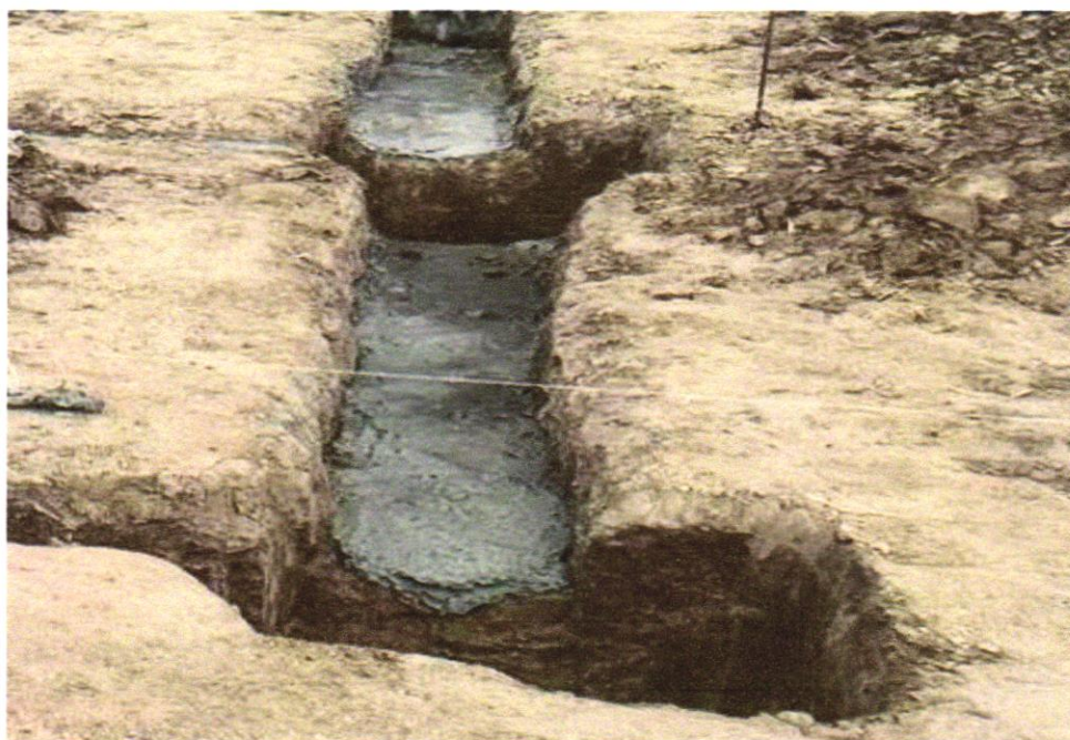
Foto 06 - COMPOSIÇÃO REPRESENTATIVA) EXECUÇÃO DE ESTRUTURAS DE CONCRETO ARMADO, PARA EDIFICAÇÃO HABITACIONAL UNIFAMILIAR TÉRREA (CASA EM EMPREENDIMENTOS), FCK = 25 MPA. AF_01/2017
