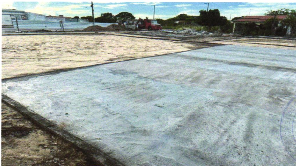
Foto 10 - CONTRAPISO EM ARGAMASSA TRAÇO 1:4 (CIMENTO E AREIA), PREPARO MANUAL, APLICADO EM ÁREAS MOLHADAS SOBRE IMPERMEABILIZAÇÃO, ACABAMENTO NÃO REFORÇADO, ESPESSURA 4CM. AF_07/2021
