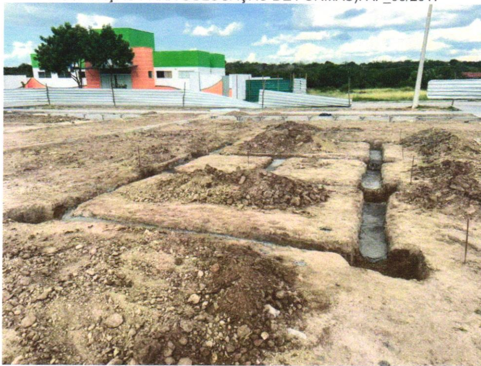
Foto 04 - ESCAVAÇÃO MANUAL PARA BLOCO DE COROAMENTO OU SAPATA (INCLUINDO ESCAVAÇÃO PARA COLOCAÇÃO DE FÔRMAS). AF_06/2017
